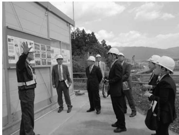
高台住宅地の造成現場を視察
