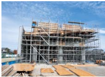
建設中の「津波避難施設大湊小南タワー」
