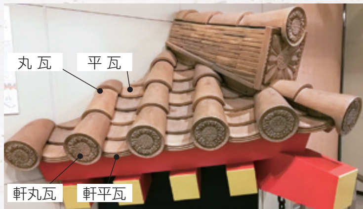
古代寺院の瓦の葺き方の例(下野薬師寺復元模型)
