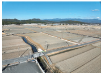
浜改田西部工区整備後
