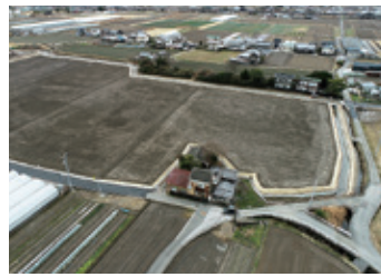
堀ノ内工区整備後
