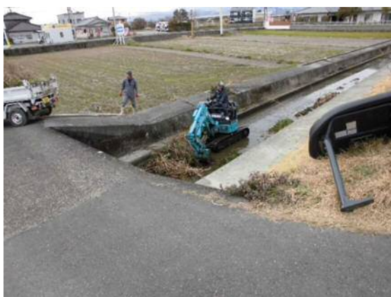
水路の浚渫作業 田役
