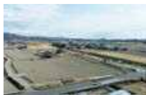
堀ノ内工区整備後
