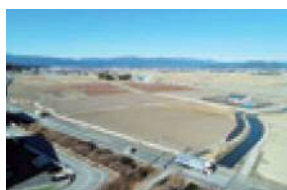
浜改田西部工区整備後
