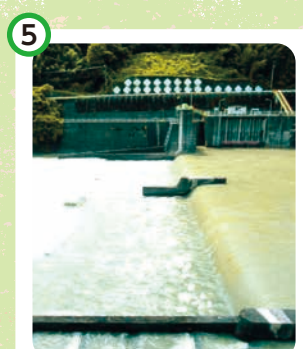
⑤ 物部川合同堰 現在の堰を見学します。
