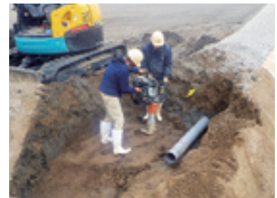
畦畔へのパイプラインの埋設状況
