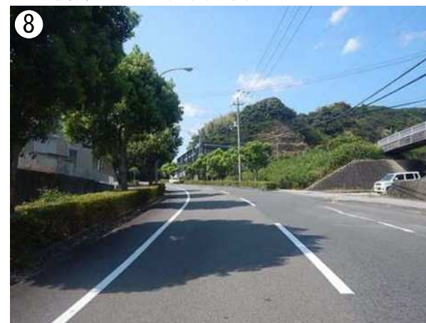
⑧ 県道から進入路付近の見通し 植樹帯により進入路の存在が把握しづらい
