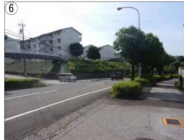
⑥ 進入路からの県道の見通し 県道の曲線区間で植樹帯があり、見通しが悪い
