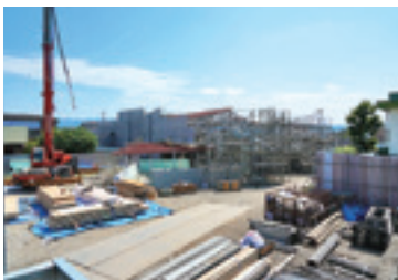
新図書館建設工事(令和7年5月)
