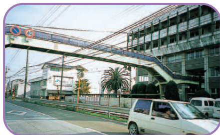
きょう 歩道橋
