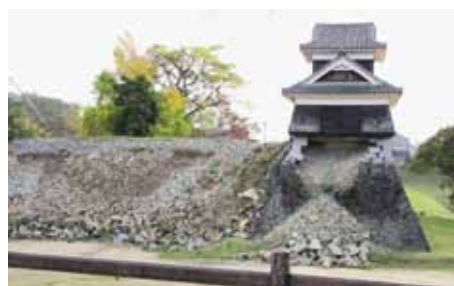
熊本城 崩れた戊辰櫓(いぬいやぐら)
